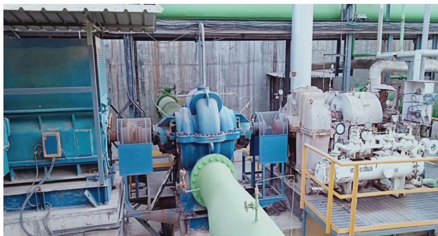
Fig-4: Actual image of the modification
